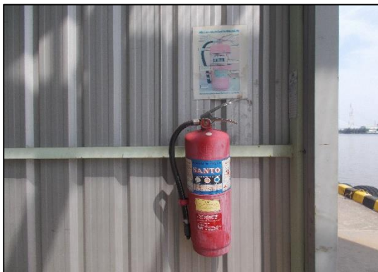
ภาพที่ 17 การจัดเตรียมถังดับเพลิง บริเวณท่าเทียบเรือ
