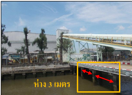
ภาพที่ 12 การออกแบบและก่อสร้างท่าเทียบเรือ ให้มีช่องว่างระหว่างเสาไม่น้อยกว่า 3 เมตร
